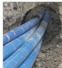
Eingezogenes Paket an Kabelschutzrohren
