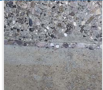
Vergleich der Oberflächen vor dem Höchstdruckstrahlen (unten) und die freigelegten Zuschlagskörner nach dem Strahlen (oben).
