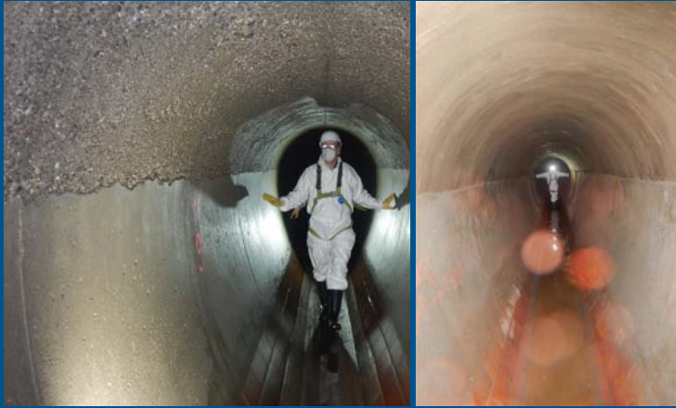
Oberfläche im Scheitel nach Höchstdruckstrahlen (links) und nach der Beschichtung (rechts)
